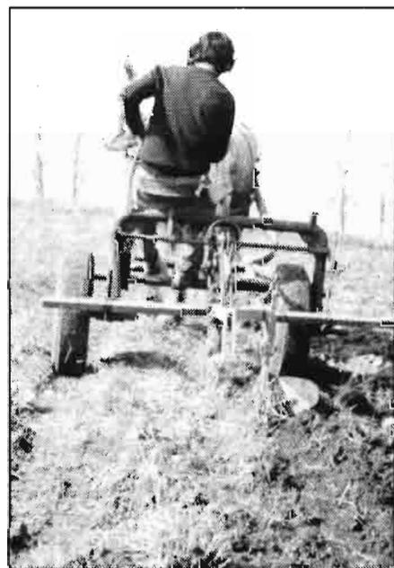
Prototipo INIA-Chile de barra portaherramientas con arado de vertederas.
