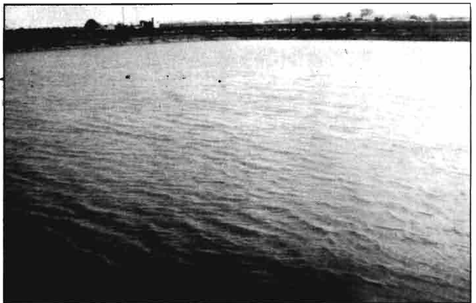
Embalse de plástico y arena de 20.000 m 3 en Torre-Pacheco.
