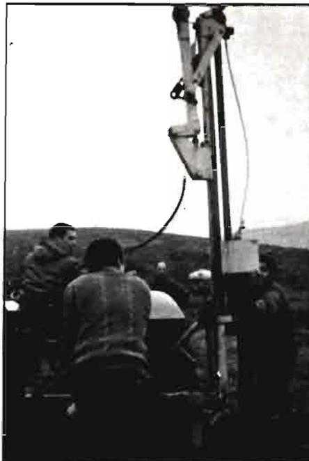
*Equipo mecánico para la colocación de postes de madera creosotada o al vacío presión a 110° de temperatura.*
