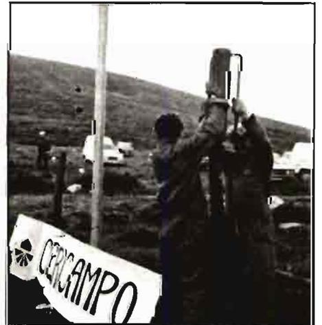
Equipo manual para la colocación de postes "tratados", para la instalación de cercas.
