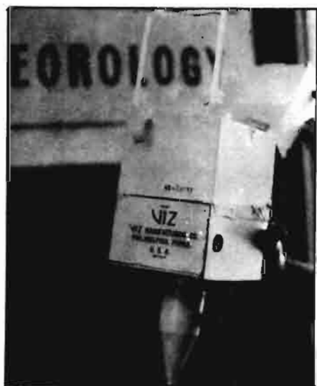
El globo sonda eleva consigo todo un equipo de medición de datos atmosféricos que transmite por radio este pequeño "satélite" no recuperable.
