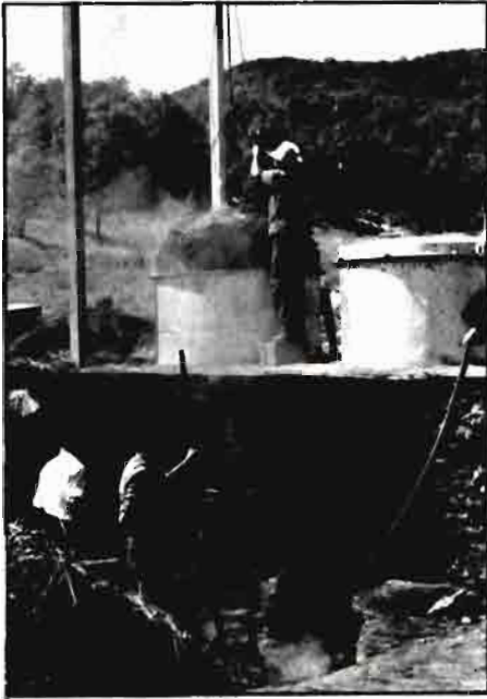
Caldera de campo con mejoras. Guadalajara.
