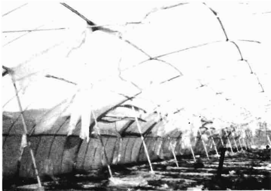
Lámina de plástico destruida
