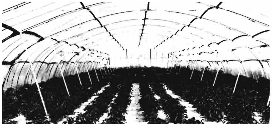
Conseguir en las instalaciones óptimas condiciones de diafanidad y estanqueidad
