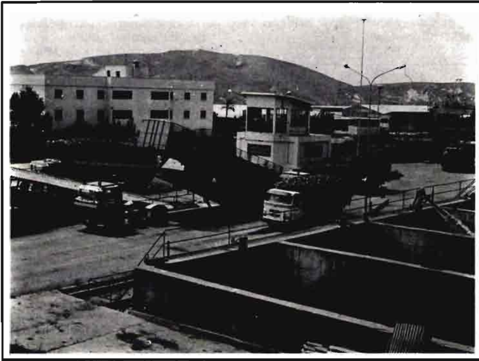
Plataformas hidráulicas para la descarga
