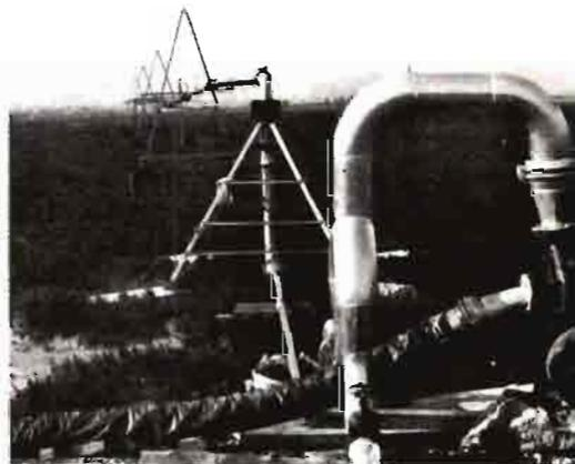
**Máquina núm. 3.—Pivote de giro desplazable por el propio tractor, que cubre por posición 3,7 Ha. Presentada por Riegos Automáticos, S. A.**
