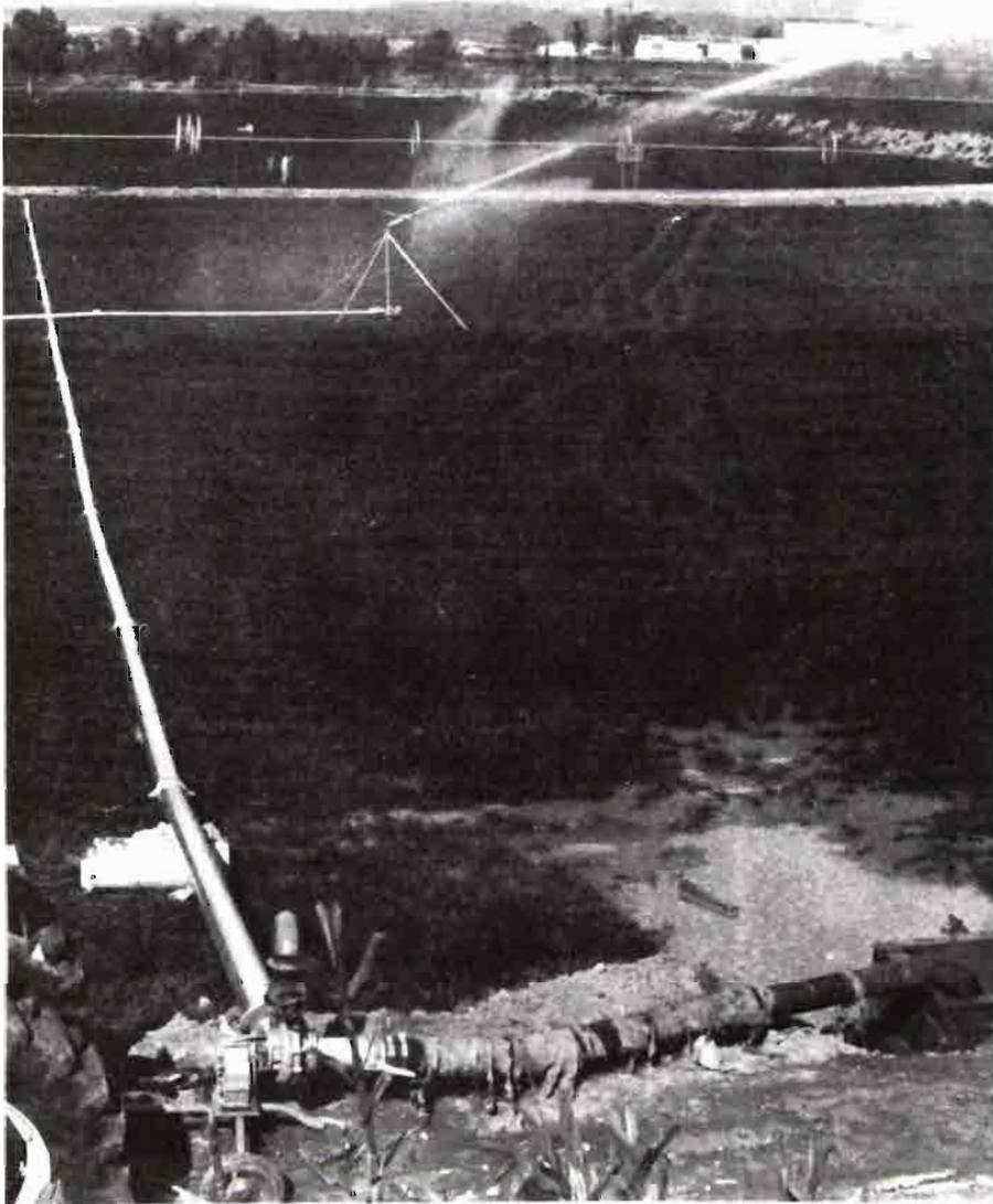
Máquina núm. 13.—En la serie de “cañones” se encontraba una instalación fija, con aspersor gigante a cada 72 m., y colocado sobre tripode alto. La casa Ibérica de Riegos, S. A., lo denomina “tores regadoras automáticas”
