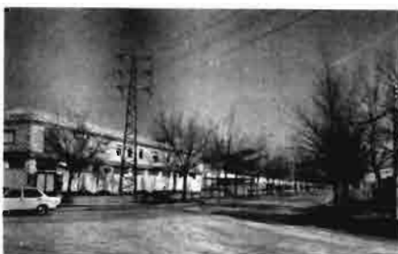
El complejo vinícola que se está construyendo en Manzanares
