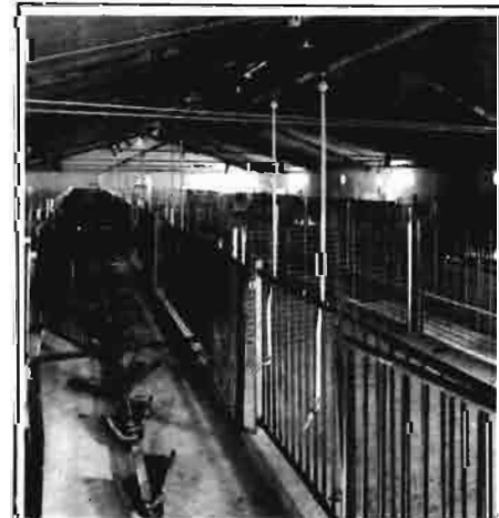
Local de cebo. Pueden apreciarse diferentes detalles de construcción. Limpieza mecanizada
