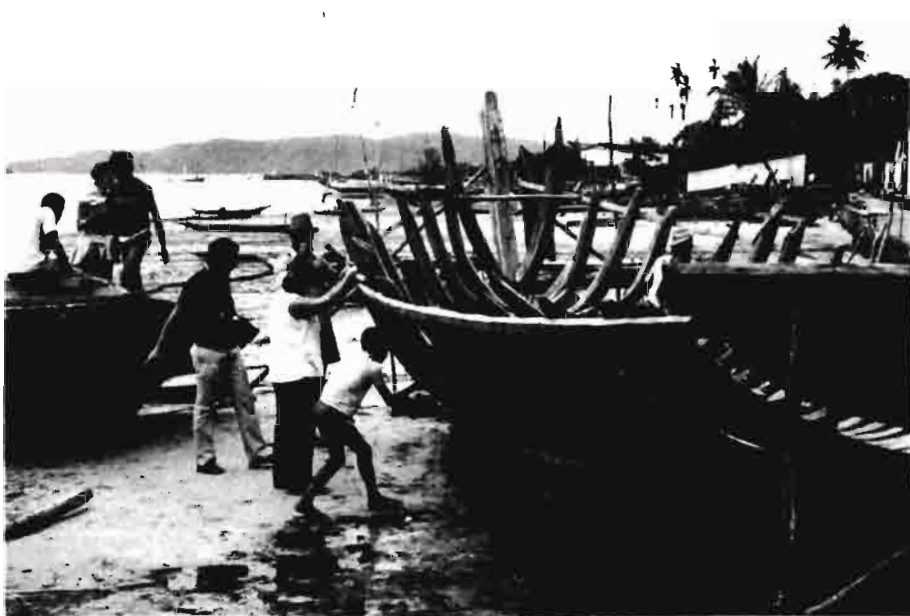
Una típica embarcación pesquera en construcción, en San Salvador de Bahía
