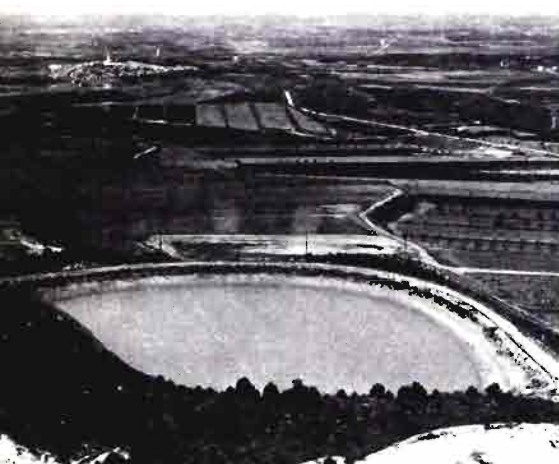
Balsa en Pla de la Font (Lérida), con 50.000 m. 3 de capacidad (acumula caudales discontinuos para racionalizar el riego).
