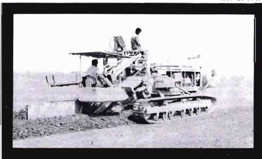
Zanjadora colocando tubo de P. V. C.
