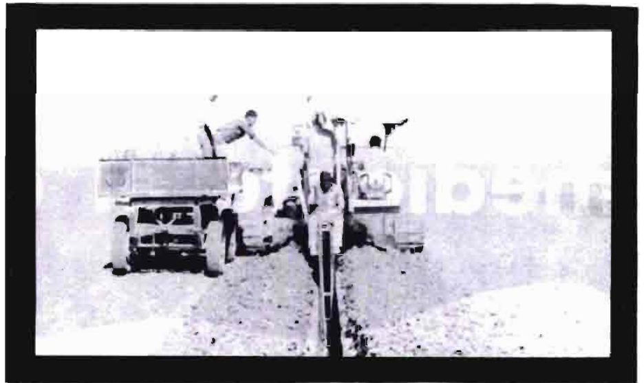
El Plan-Laser dirigiendo una máquina de rejón colocando tubo de P. V. C.
