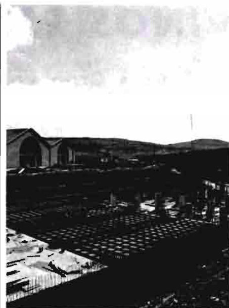
Construcción de nuevas cavas
