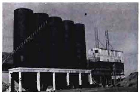
Batería de silos para granilla y orujo
