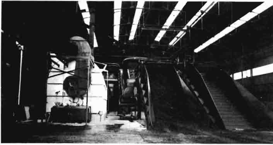
Instalación de deshidratación de forrajes
