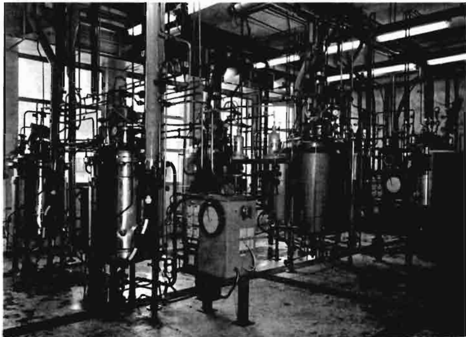
La creciente demanda de vacuna antiaftosa ha obligado a montar nuevas y complicadas instalaciones donde por métodos modernos se fabrica vacuna de gran calidad y en cantidad suficiente. He aquí una moderna fábrica, en España
