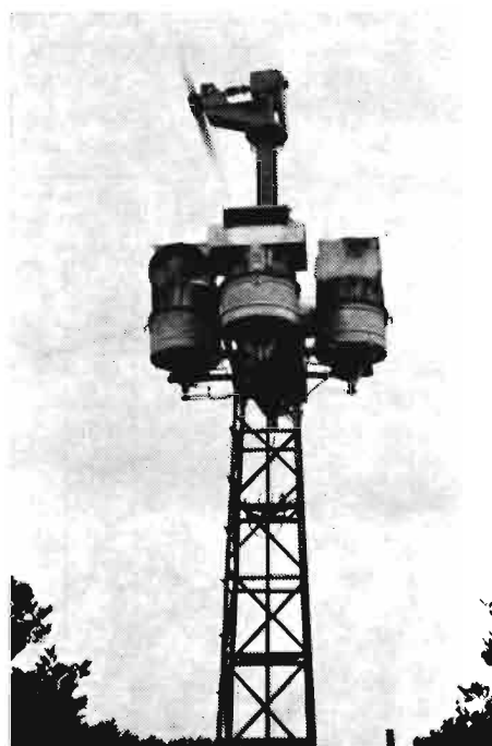
Aparato mixto calefacción-ventilación instalado en Torrente (Valencia)
