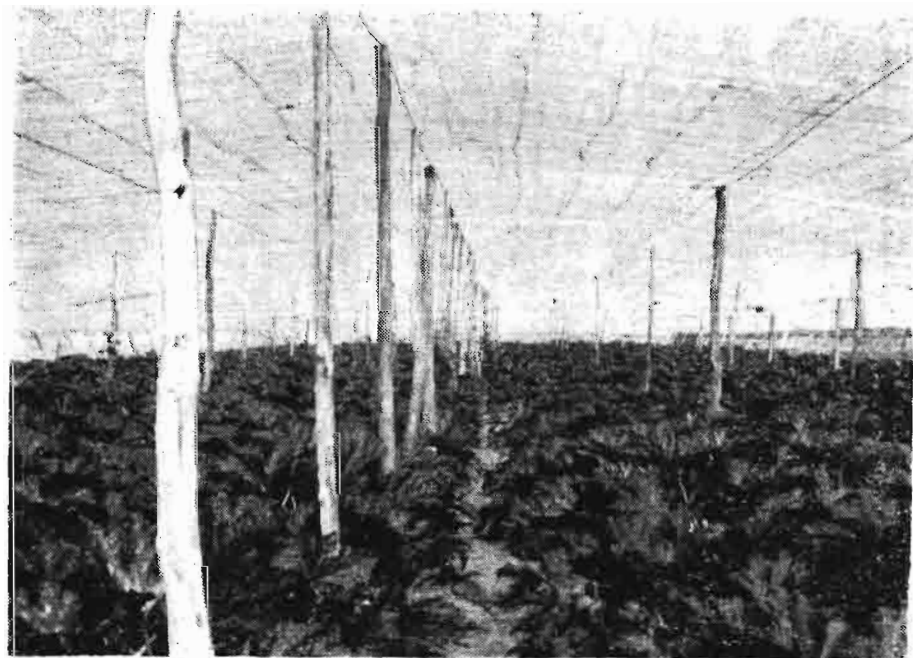
Cultivo de pimiento bajo invernadero de polietileno tipo «semicircular» instalado en el campo de Dalías (Almería). Invernadero de grandes cruces, con correas laterales a 2,50 metros de altura
