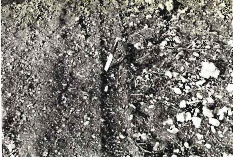
Número 13.—Obsérvese la trituration de las piedras después de la pasada de la máquina
