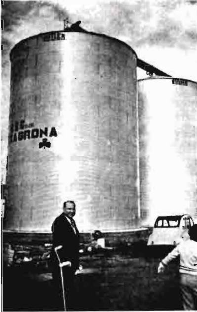
Depósitos de maíz en Argamasilla de Alba
