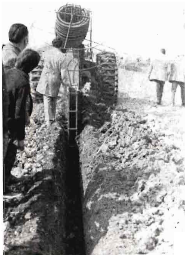
VISTA POSTERIOR DE UNA MAQUINA PARA COLOCACION AUTOMATICA DE TUBERIAS DE MARCA RADHAL
