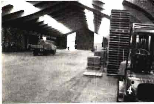
«Veiling» de Westland Nord: nave de acopio y exhibición de mercancías
