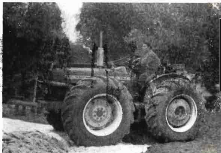
El vibrador de troncos de gran potencia, aunque diseñado originalmente para la recolección mecanizada de los frutos secos, puede ser eficaz, de cara al futuro, para la recolección de la aceituna de molino, en la esperanza de que podrán reajustarse ciertas exigencias económicas y unas variantes más adaptadas a las condiciones de nuestro olivar
