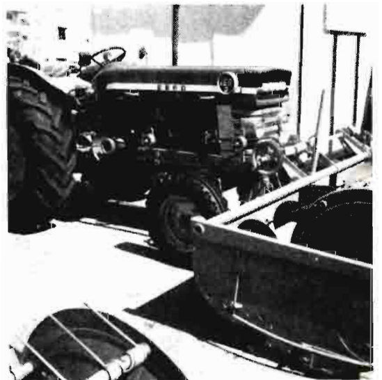
Segadora acondicionadora Zazurca, tipo frontal. Ingenioso sistema de transmisión a base de poleas y correas
