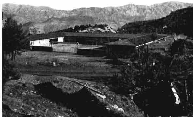
Aprisco construido por los Servicios Forestales en monte de utilidad pública
