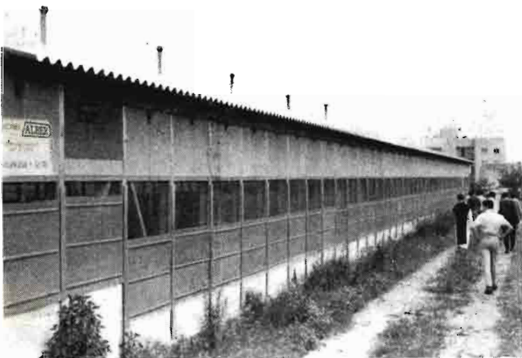
Exterior de un gallinero prefabricado para pollos para carne en la Granja Solé, de Bascara (Gerona). (Foto Reosa.)
