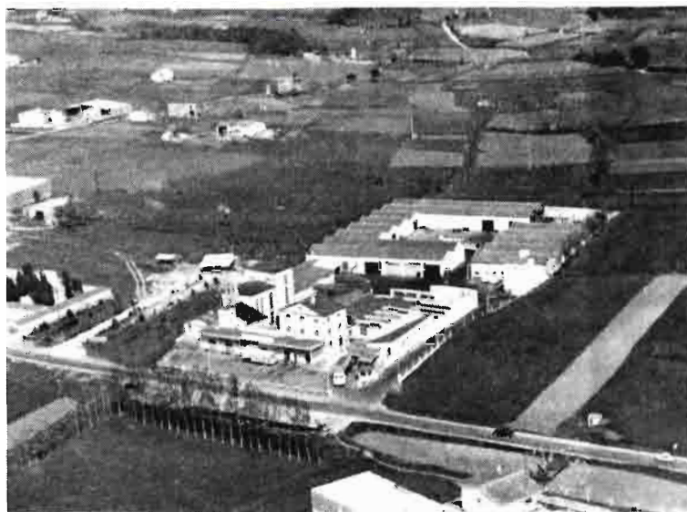
Vista general de la planta de Vidreras (Gerona)
