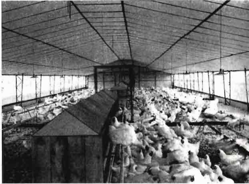
Gallinero prefabricado de la Granja Fontanals, de Vilafranca del Penadés (Barcelona). (Foto Reosa.)
