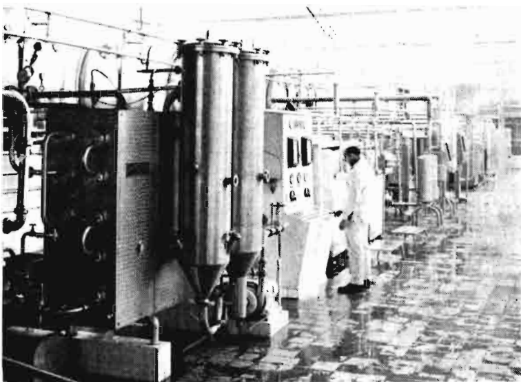
Sala de elaboraciones y tratamientos: pasterización, presterilización, homogenización y desodorización
