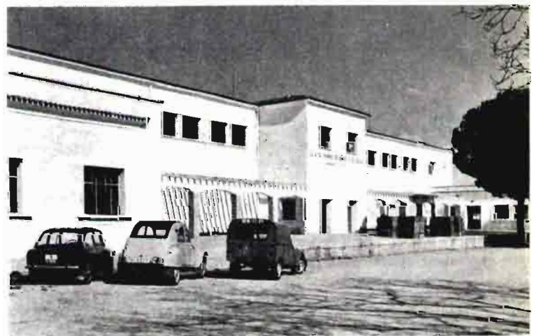
Exterior de una de las cámaras frigoríficas destinadas principalmente a la conservación de manzanas
