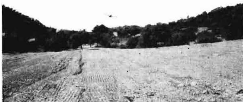
Doce meses fueron precisos para situar la explotación en esta fase de trabajo
