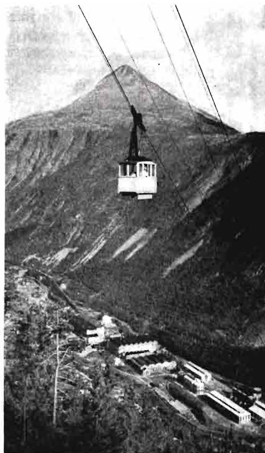
La topografía de Noruega proporciona energía eléctrica a bajo precio. Para su «exportación» es transformada en abonos nitrogenados
