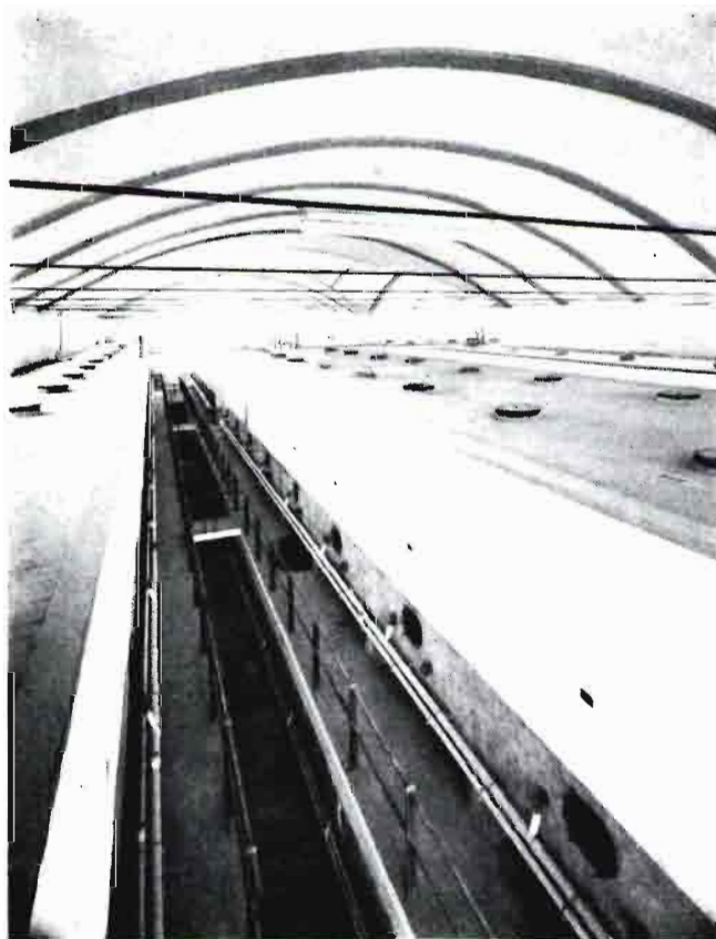
Depósitos de almacenamiento de vino de la Cooperativa Covides
