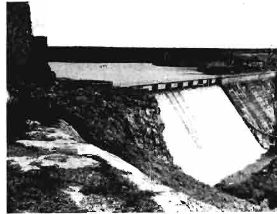
Embalse del estrecho de Peñarroya sobre el Guadiana.
