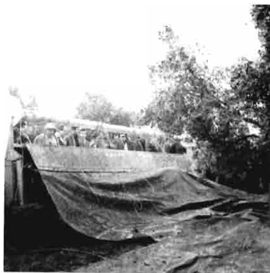
Entre el material auxiliar supuso una novedad un aparato recolector (a la derecha) que funciona simultáneamente con un vibrador, que consiguió escasos rendimientos en las condiciones de los Certámenes, de procedencia inglesa
