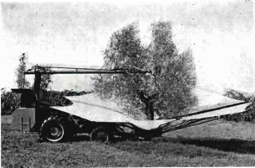
Vibrador recolector de fabricación italiana. La aceituna desprendida del árbol se recoge sobre un extenso abanico plegable provisto de un orificio en el fondo para su posterior depósito y limpia en una tolva incorporada a un lateral de la máquina
