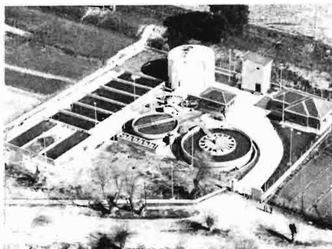
Fig. 3.—Como ejemplo de realizaciones que cabe extender a nuevos núcleos de población por tener ya la documentación de los hechos, presentamos la instalación depuradora de 3.000 m 3 por día de agua residual que Inflico Española, S. A., ha construido y puesto en marcha en la estación depuradora de El Pardo (Madrid)
