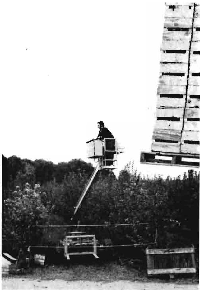
La plataforma recolectora COSMAG en una posición elevada. Puede observarse en la parte baja de la máquina el bastidor donde se coloca el cajón paletizable que va almacenando los frutos. El operario, desde la plataforma, acciona también el desplazamiento de la máquina
