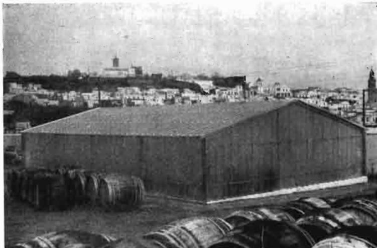
Invernadero experimental, actualmente instalado en Lucena. Capacidad para unos 60 bocoyes. El aprovechamiento del calor solar puede acelerar notablemente la fermentación en determinadas zonas
