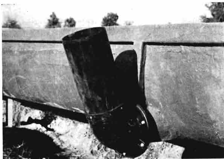
Toma de riego Arto de polipropileno, en acequia de plástico. Huesca
