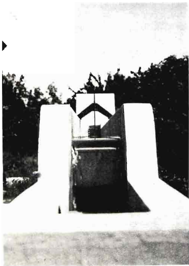
Canal para aforo de caudales con aguja medidora
