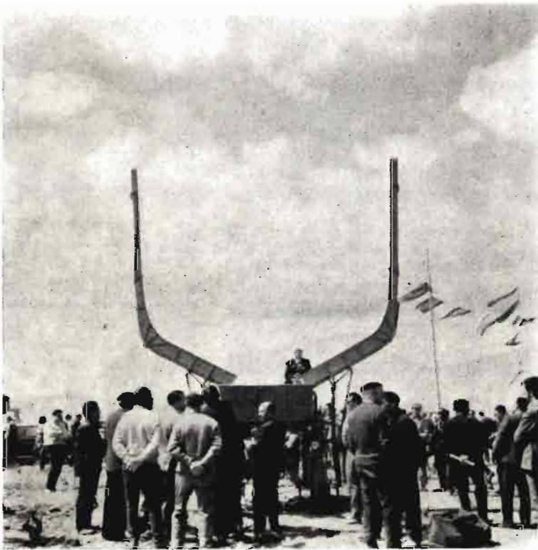
En la Demostración de Alfamen llamó la atención la presencia de este equipo colector y cargador de racimos. He aquí el equipo con los «brazos cargadores» en alto, en posición de carga o vaciado de los racimos sobre el depósito central
