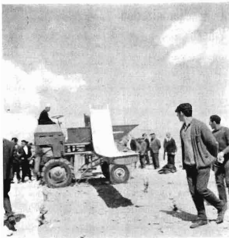
La misma maquinaria con sus «brazos cargadores» en posición horizontal y aptos para que los vendimiadores depositen en ellos los racimos cortados
