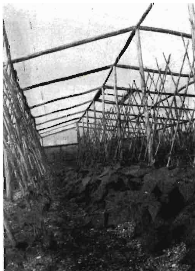
Interior del invernadero de rollizos. La fotografía está tomada el 9 de febrero de 1969, treinta y cinco días después de la siembra de judías. El suelo está enarenado
