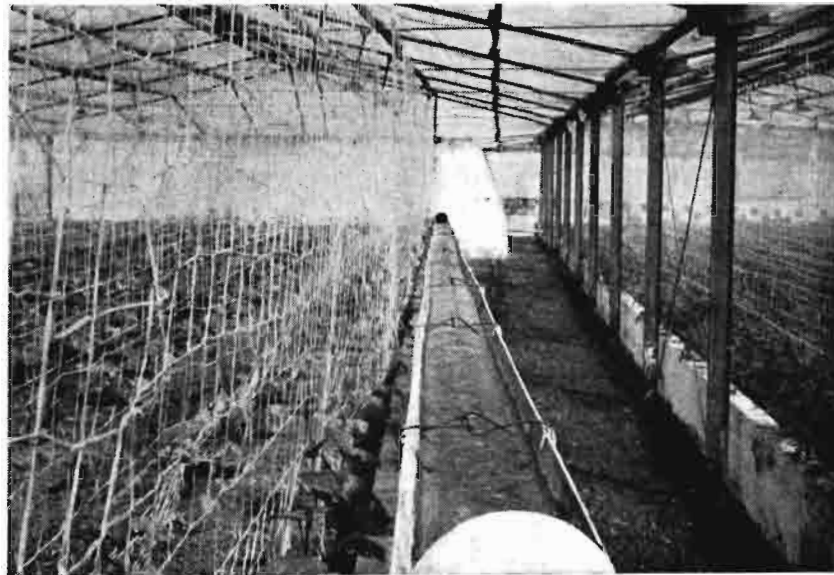
Canal de conducción de la solución
