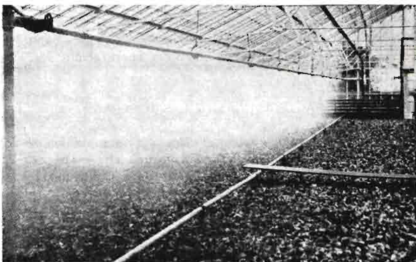
Sistema de tubería de boquilla para el riego por aspersión que cubre la mitad de la anchura de un invernadero. La tubería se hace girar a mano mediante la palanca que se observa en el ángulo superior izquierdo. (Del libro de la FAO «El empleo del riego por aspersión».)
