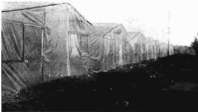
Exterior de un invernadero construido a base de rollizos de madera
