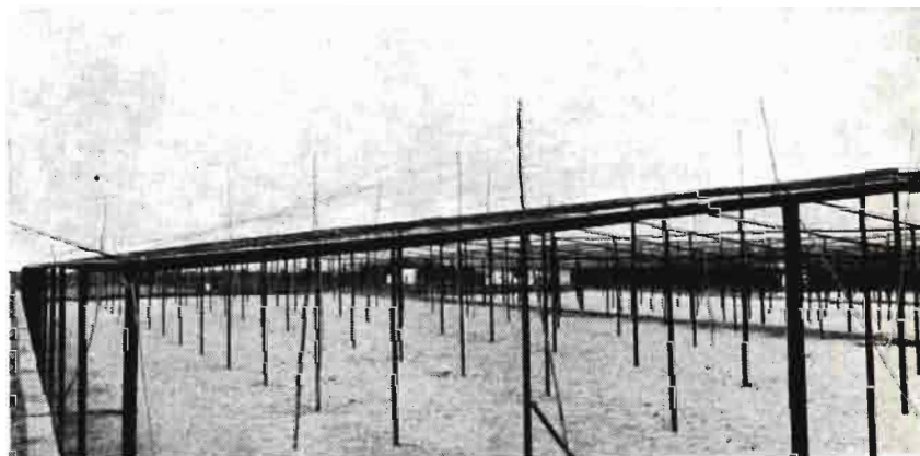
Preparación de la malla metálica para la colocación del plástico de la cubierta
