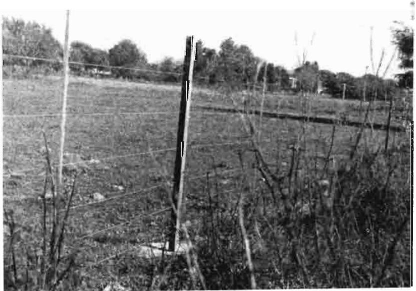
Abajo, poste intermedio cimentado y pletinas. La distancia entre postes intermedios es de 10,5 m.; entre cada dos postes intermedios van seis varillas a 1,80 m. una de otra
