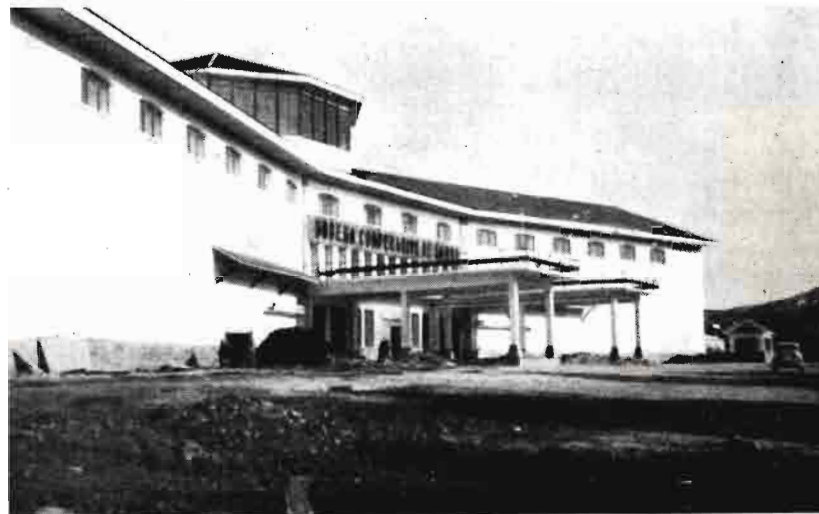
Bodega cooperativa de la Rúa. Fachada principal. Caseta de báscula y tolvas de recepción de la uva
