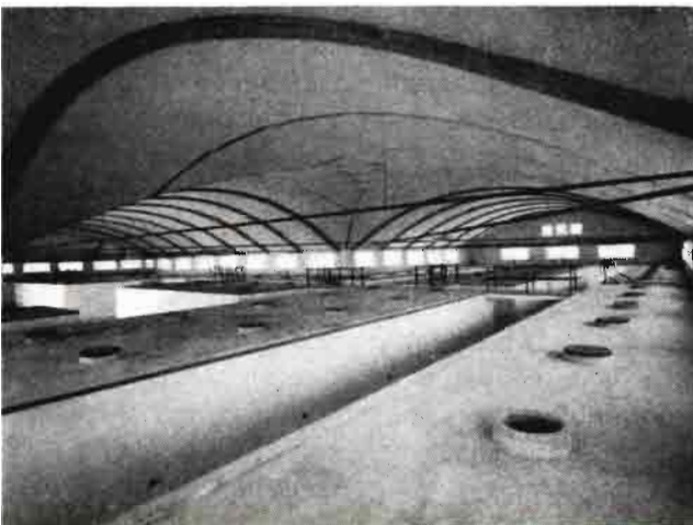
Cooperativas vinícolas del Panadés. Crucero de naves de depósitos de 30 metros de luz
