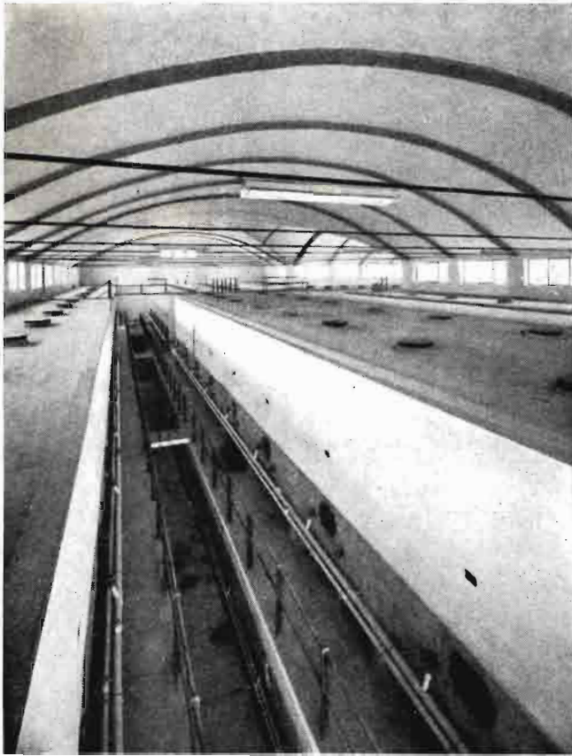
Cooperativas vinícolas del Panadés. Detalle de naves de depósitos en dos pisos
