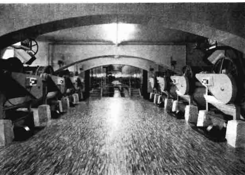
Moderna instalación de prensas horizontales de Segura Hermanos, en Torrelavid
