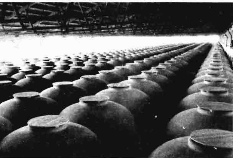
En la zona de Moriles-Montilla se producen vinos de gran calidad para ser sometidos a crianza en botas de roble. Después de la fermentación, realizada en depósitos de hormigón armado como estos de la Cooperativa de Montilla, sólo un exiguo porcentaje de estos vinos es sometido a crianza. (Foto González.)
