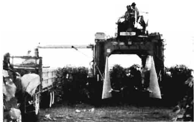
Fig. 3.—Cosechadora en el momento de terminar una línea. Obsérvese la cinta transportadora descargando sobre los cajones que van en el remolque. (Foto del autor.)
