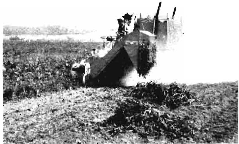
Cosechadora integral autopropulsada, en régimen de trabajo. Se observa en primer plano la tolva de hojas y los montones que va dejando la descarga automática
