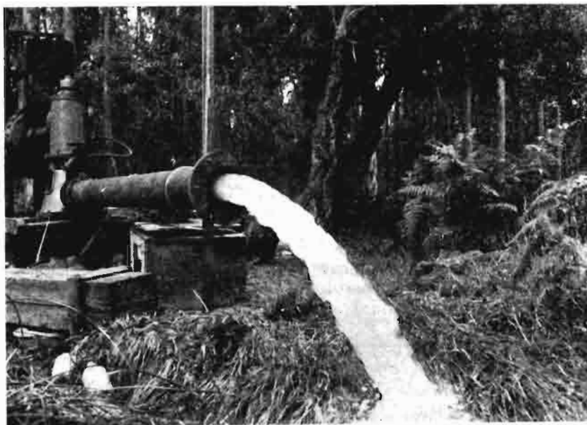
Trabajos de sondeos de la zona del Rocío para abastecimiento de aguas a Rociana, Almonte y Bollullos de la Mitación
