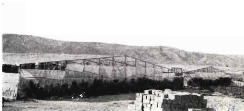
Invernadero con estructura metálica en arco
