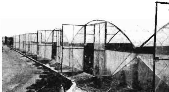
Conjunto de invernaderos de estructura metálica en arco
