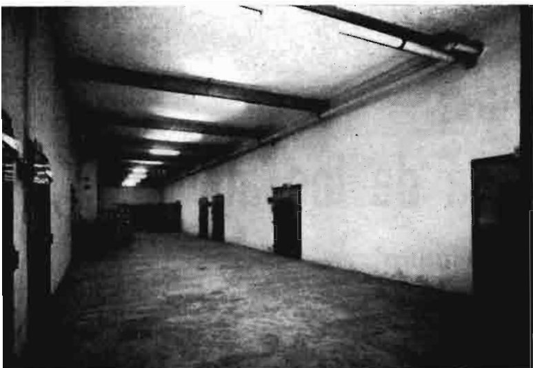
Pasillo de entrada a cámaras frigoríficas de una Central Hortofrutícola.
