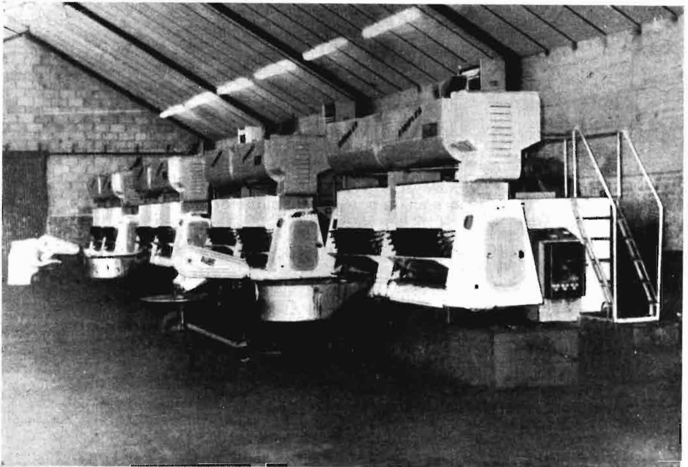
Almazara racional cooperativa, donde las modernas máquinas dominan el espacio, dentro de un sencillo edificio, lo estrictamente indispensable para una explotación económica. (Extractores con su triturador incluidos, distribuidores de la pasta para su dosificación en los capachos y las prensas complementarias para el desecado o agotado final del orujo.)
