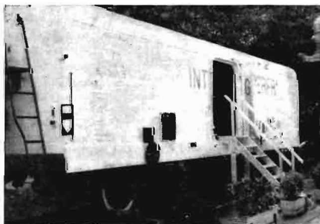
Vagón frigorífico italiano, construido totalmente de fibra artificial, con las ventajas de menor peso y mayor capacidad. El hielo o las mezclas frigoríficas utilizadas se almacenan en los extremos del vagón y un sistema de ventiladores eléctricos interiores son los encargados de ir renovando el aire frío.
