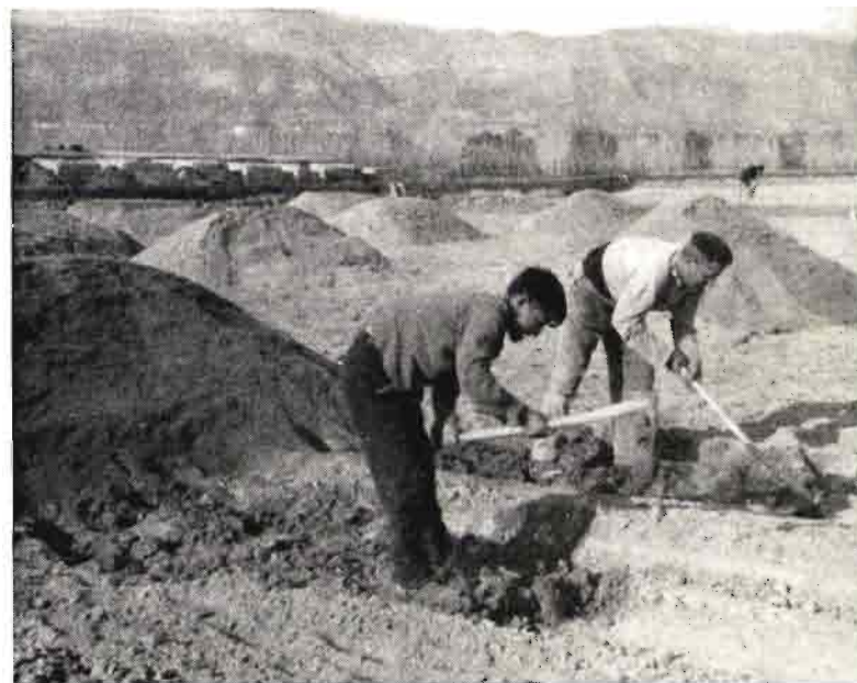
Cavando las rodadas dejadas por el camión con el fin de dejar el suelo completamente blanco. Al fondo, dos operarios extienden los montones de arena.
