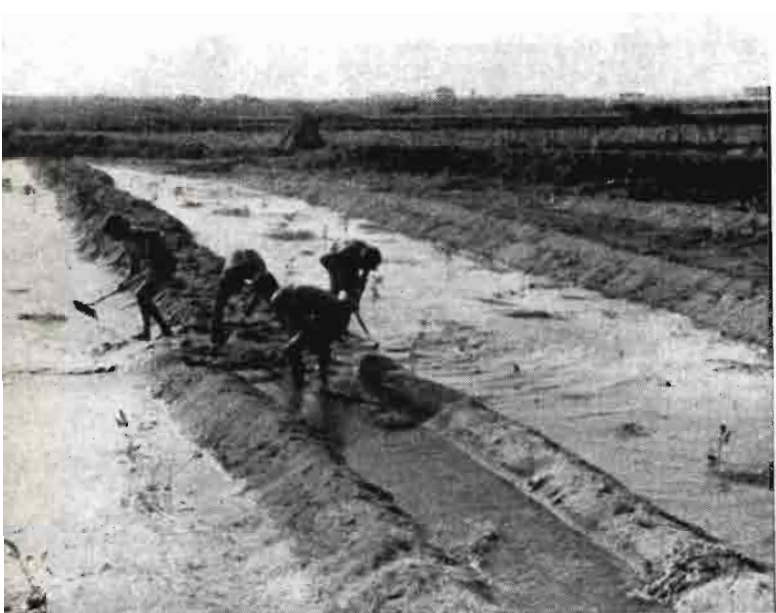
Operación de lavado de arena. El agua corre entre dos caballones de arena sucia y va quedando limpia en un solo cordón detrás de los operarios.
