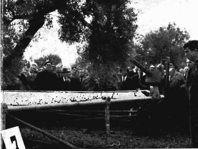
Un bastidor recoge las aceitunas que el vibrador se encarga de derribar del árbol.
