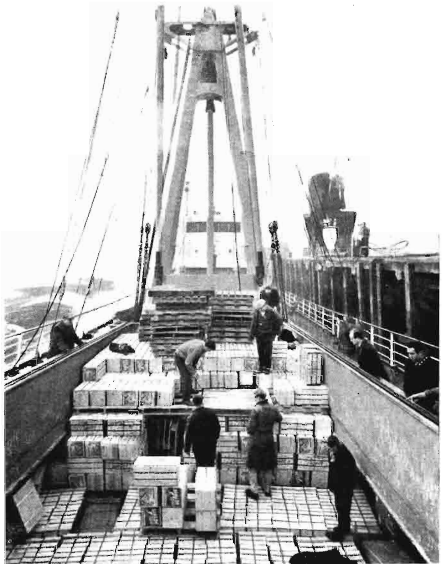
a) Operaciones en firme
