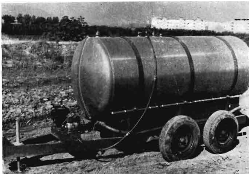
Fig. 9 Tanque nodriza con compresor de aire para hacer el transvase.
