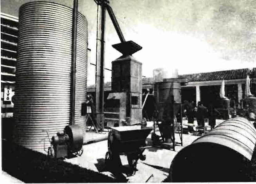
Silo para cereales de 5, 10 y 25 vagones de capacidad, junto a un secadero de grano de 2.500 kgs./hora.
