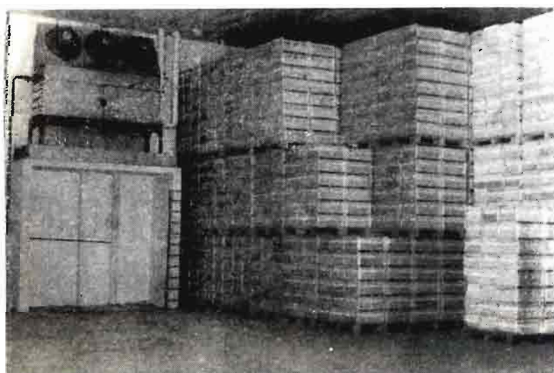
Una vista interior de la cámara y su evaporador. Altura útil, seis metros
