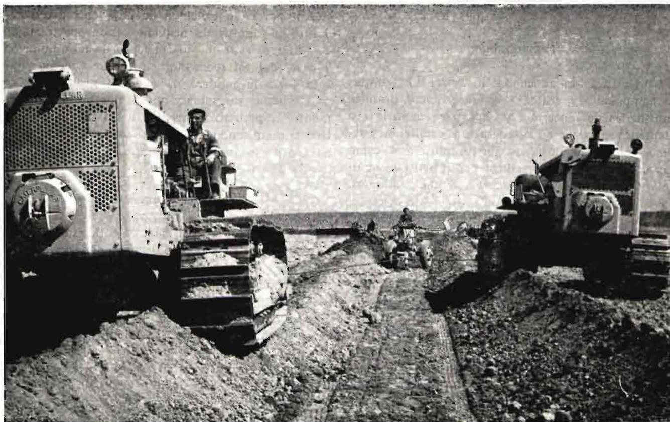
Abrezanjas Briscoe, que, con tracción de cuatro tractores de 100 CV., es capaz de abrir mensualmente 1.000 kilómetros de zanjas de saneamiento en jornadas de ocho horas.
