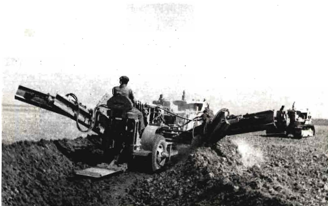
Estos poderosos abrezanjas deberán relevar a los hombres de la penosa labor de abrir desagües y limpiar las regueras de saneamiento.
