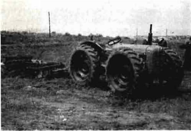
Tractor Super-Ebro con tracción a las cuatro ruedas.
