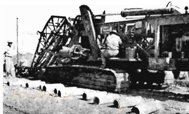
Foto núm. 1.—Máquina para colocar los tubos de drenaje. Según los terrenos, se colocan los tubos a profundidades de cuatro a diez pies. Esta máquina permite colocar por hora los tubos correspondientes a una longitud entre 200 y 400 pies.
